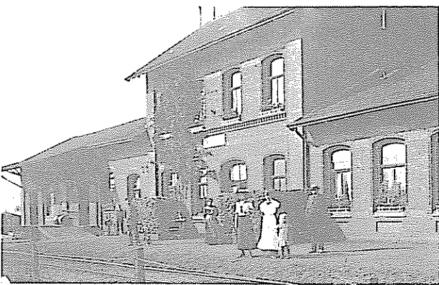
Bahnhof mit Rampe links
