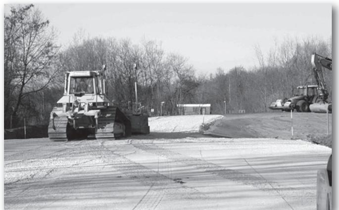
Herrichtung des Geländes und Aufschüttung des Mühlenhügels durch die Firma Niehaus.
